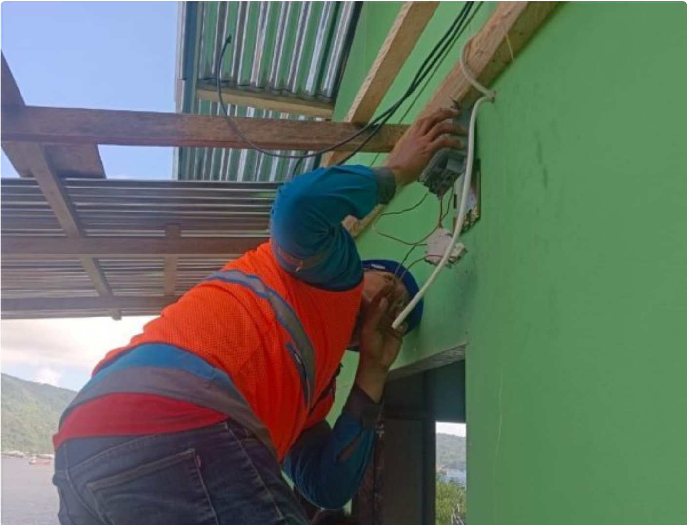
Pemasangan Instalasi RTLH oleh Satgas TMMMD Ke-116 Kodim 1310 Bitung
