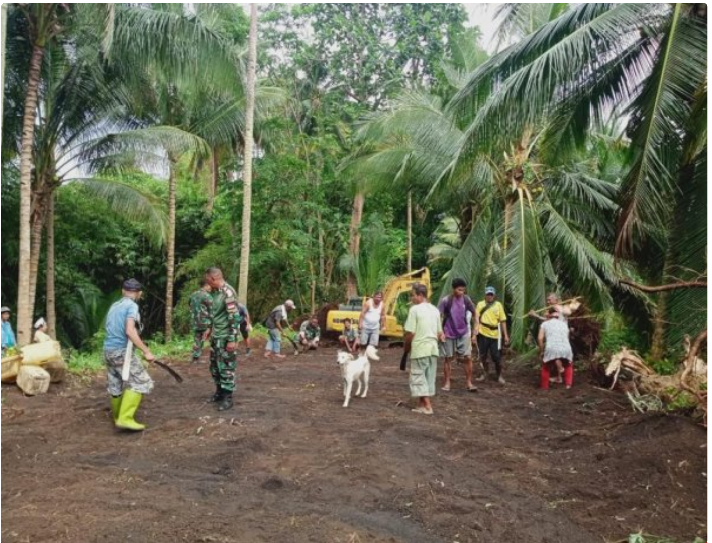
Warga berbaur bersama Satgas TNND Ke-116 Kodim 1310 Bitung dalam kerja Pembangunan Jalan Pertanian
